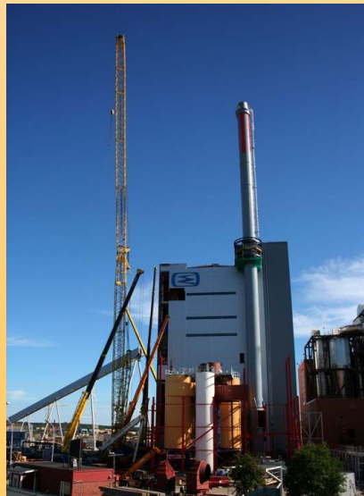
Uppförandet av den nya pannan är i full gång!
